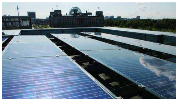
Solaranlage auf dem Dach des Bundeskanzleramtes (Quelle: Bundesbildstelle / Bienert)
